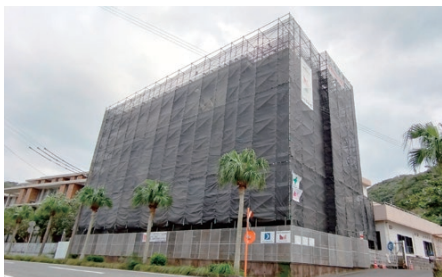
建設中の複合施設
