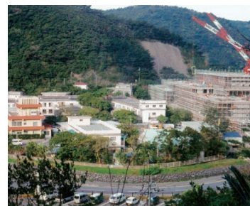
旧病院施設と、隣接地に建設中の現病棟 (右、2002年ごろ)
