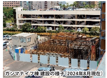
ガンマナイフ棟建設の様子(2024年8月現在)
